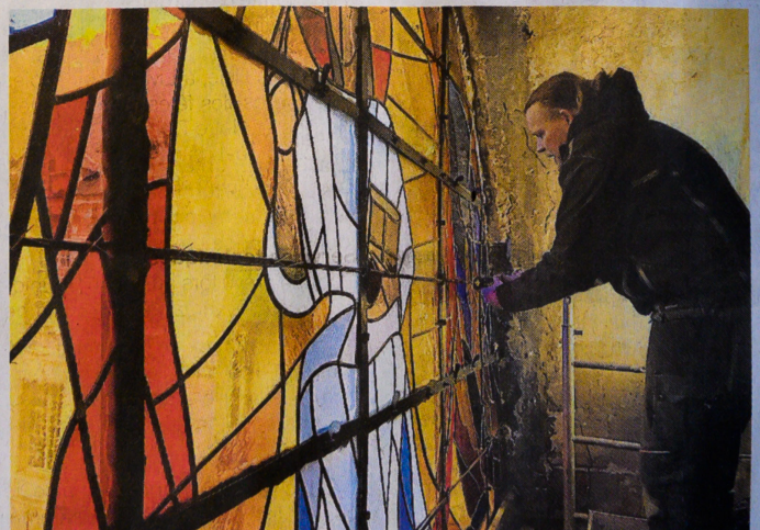
Daniel Stettler fixe le vitrail avec des fils de fer.
